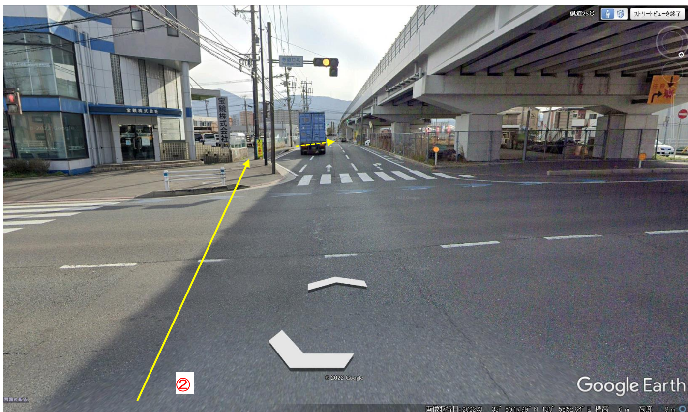
高架橋迂回路 地上画像 ②寺迫口北交差点 歩道進入路
