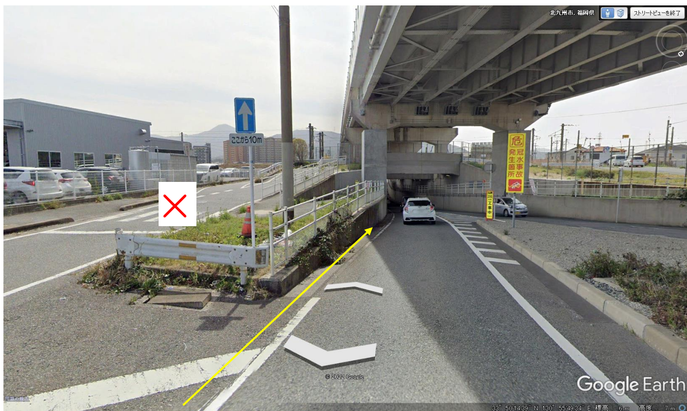
高架橋迂回路 地上画像 迂回地下道（写真で見える左側側道の分岐直進は通行しないでください）
